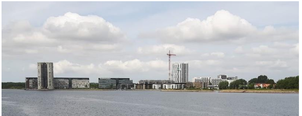
På Nørre Sundby-siden rejser højhusene sig som planter der kæmper om lyset. "Høje Brygge" til venstre i billedet er to 53 m høje sammenbyggede cementsiloer, der i sin tid blev lavet om til boliger. Her er terrasser med udsigt til øst og vest for paradiset uden læ for vinden. Alligevel er det dyre mondæne andelsboliger, som så meget andet i området. Bygningen, der står i skyggen af siloerne, laves pt om til ungdomsboliger. Geodatastyrelsen har vi i midten, og til højre herfor under en byggekran endnu et højhus til de velbærgede der krabber sig mod himlen. (se nedenfor)
