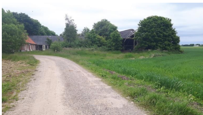
Her bor tilsyneladende ikke nogen. Udhusene er ved at styrte sammen (Foto: JV)
